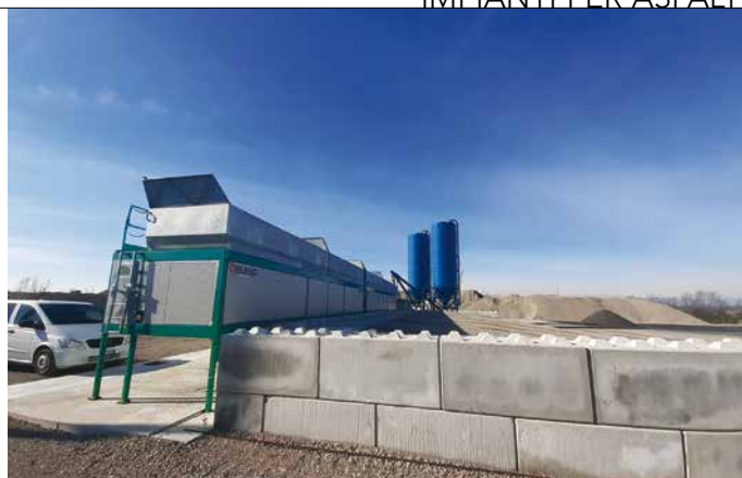
4. La rampa di carico delle vasche è stata contenuta con i moduli prefabbricati Betonblock prodotti dalla stessa Eco-Works con le casseforme commercializzate dalla Blend Plants
